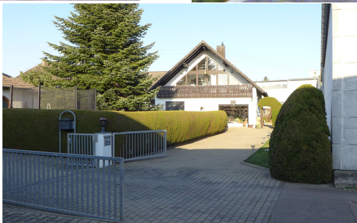
Eingeschossiges Einfamilienhaus mit steilem, ausgebautem Satteldach, 1951 nach Brand des Vorgängerbaus errichtet, Erweiterungen 1978 und 1985
