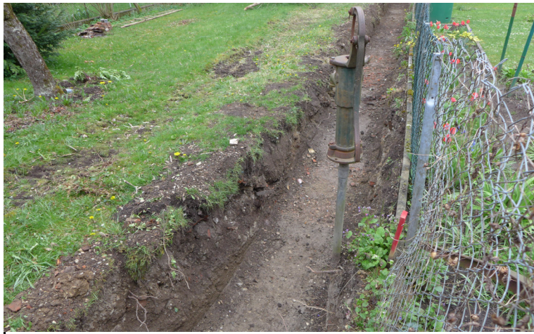
Anschnitt der Zwingermauer in den Gärten zw. WB24 und WB27 im Rahmen der Verlegung der Fernwärmeleitung, April 2020
